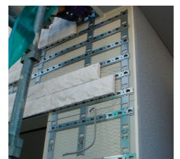
NC新シュタルネット工法
